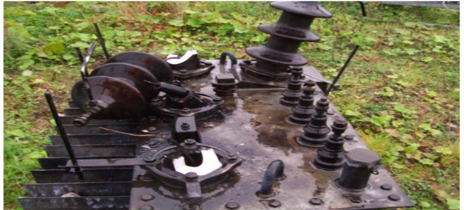
Transformator skadet av lynnedslag
